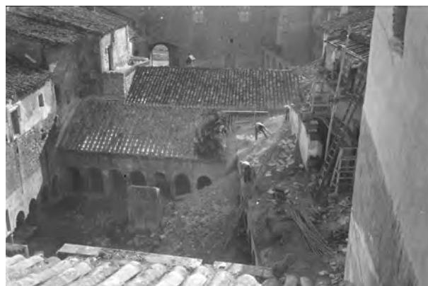
FIGURA 18. Treballs de restauració de les teulades de la canònica de Santa Maria de Vilabertran. (Fons Joan Subias Galter de l'Arxiu de l'Institut d'Estudis Catalans).
